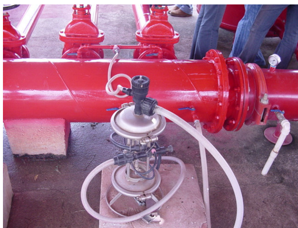
Figura 18 – Injetor de fertilizante com acionamento hidráulico para fertirrigação
